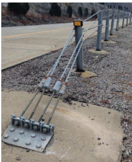
სურ. 3,4. საბაგრო ბარიერების კონსტრუქციული გადაწყვეტილებები ამერიკის შეერთებული შტატების მაგალითზე
