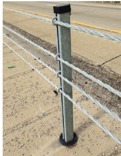
სურ. 3,4. საბაგრო ბარიერების კონსტრუქციული გადაწყვეტილებები ამერიკის შეერთებული შტატების მაგალითზე
